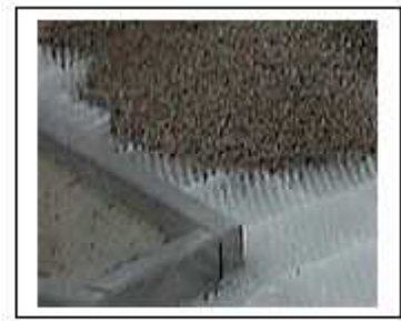
Bordures en béton
