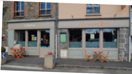
Travaux de réfection de peinture à la crêperie L'Arbre en Bois
