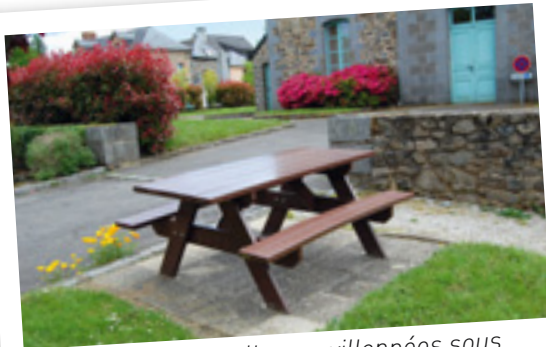
Mise en place de dalles gravillonnées sous la table de pique-nique dans le bourg
