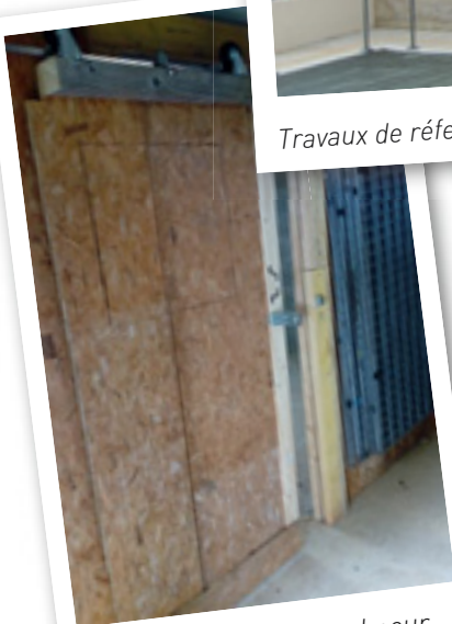
Réalisation d'un local pour l'APE situé à l'atelier technique
