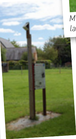
Installation de lampes Leds sur le chemin piétons entre la rue de la Liberté et le Clos de la Rabine
