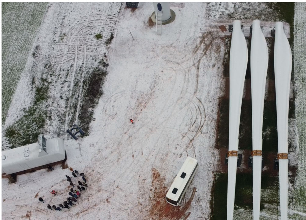
Porte ouverte organisée lors de la phase chantier par IEL, en décembre 2022
