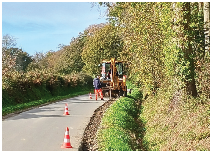
Réfection des accotements le long de la route de la gromillais
