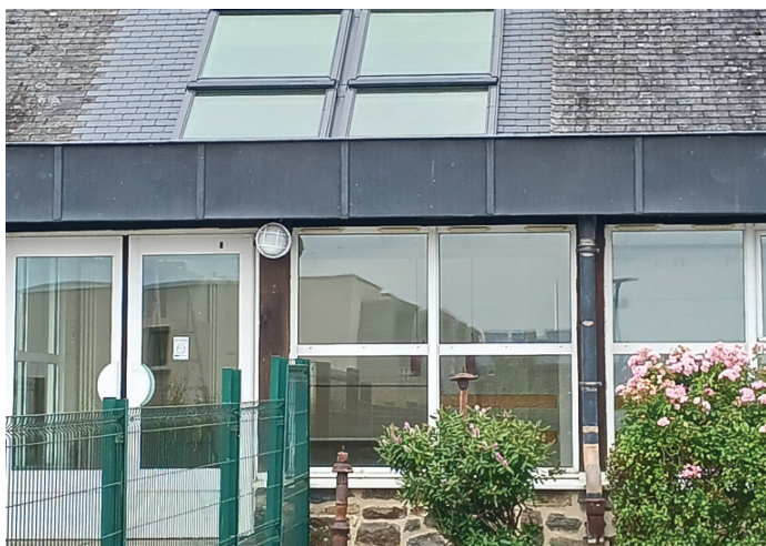
Après l'intervention de deux entreprises pour la réfection de la verrière du bâtiment scolaire. Travaux de peinture
